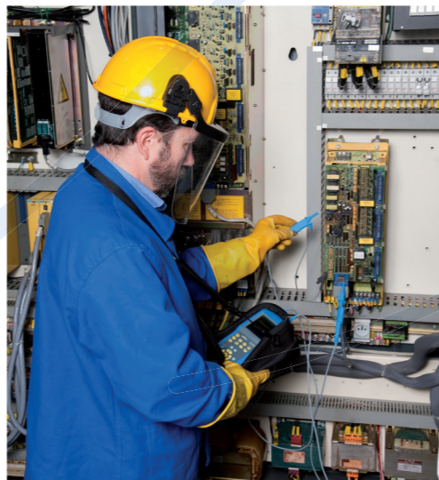
En la parte control-comando electrónico de una máquina herramienta, comprobación del funcionamiento correcto.
