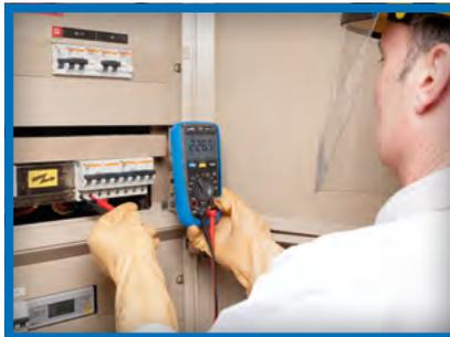
Las operaciones de **mantenimiento eléctrico** se ven optimizadas con la medida de tensión de baja impedancia  $V_{\text{LowZ}}$ , que permite librarse de las tensiones parásitas causadas por el material informático u otro durante intervenciones de mantenimiento en oficinas o edificios terciarios.
